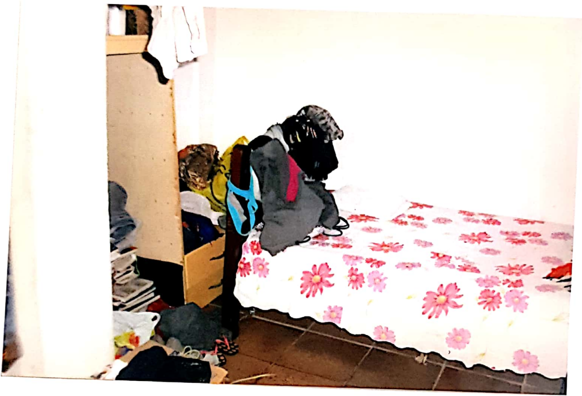
foto nº9 - interior da sala/dormitório do apto nº 101 avaliando, com piso de lajota cerâmica e paredes com massa corrida e látex
