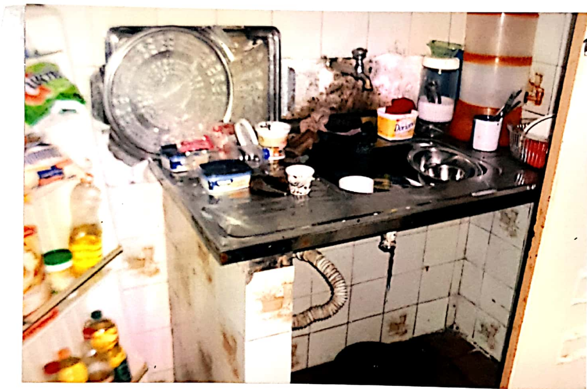
foto nº 14 - cozinha da kitinete com piso cerâmico e pia de tampo de inox.
