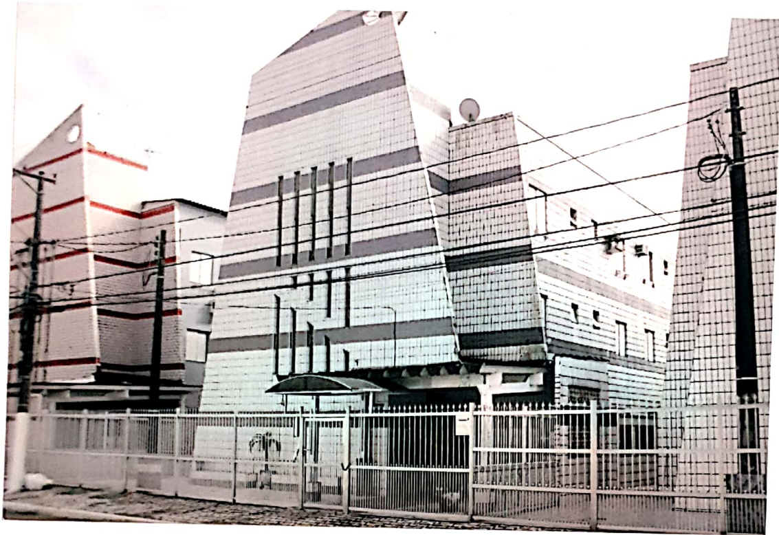
Foto nº 01 – fachada do Edifício Turmalina, frente para Rua Kikusaburo Tanaka, do apartamento nº 101-avaliando,
