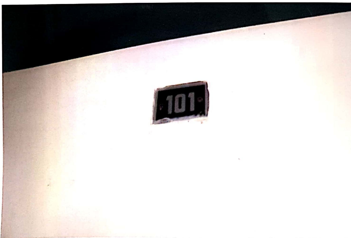
foto nº 6 - detalhe da fachada
