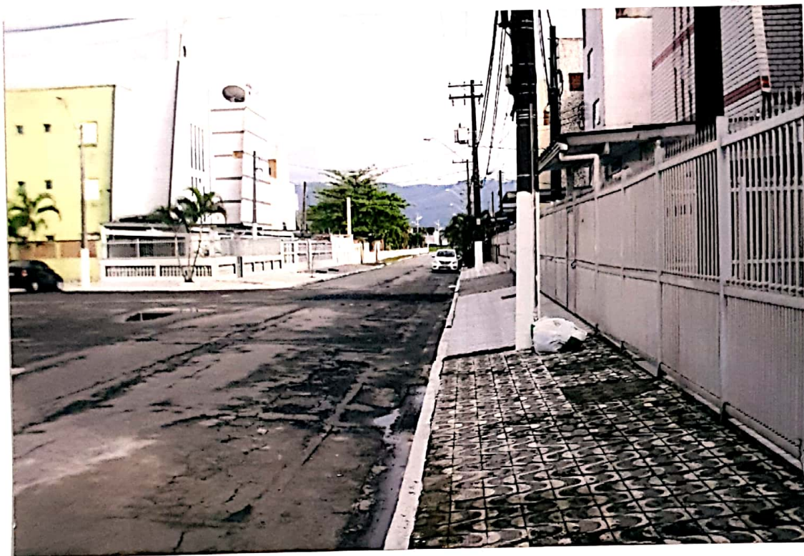
foto nº 3- vista da Rua Kikusaburo Tanaka dotada de todos melhoramentos públicos usuais.
