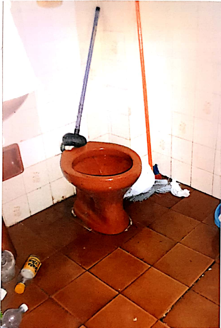
Foto nº 13 – banheiro com piso de cerâmica, paredes de azulejos, e louça sanitária de padrão comercial.
