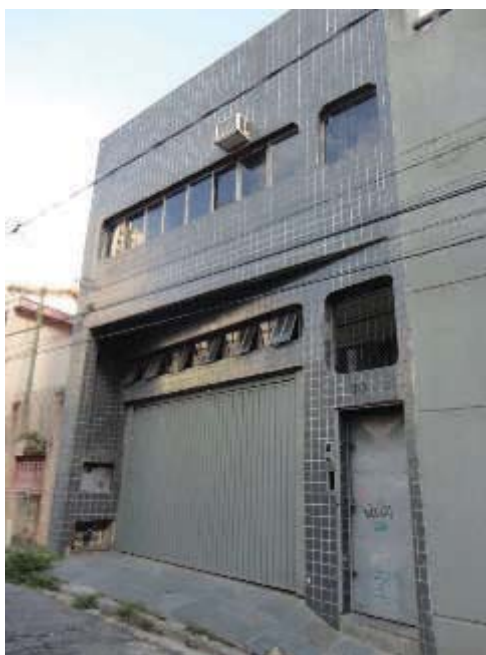
Vista frontal do imóvel avaliando.
