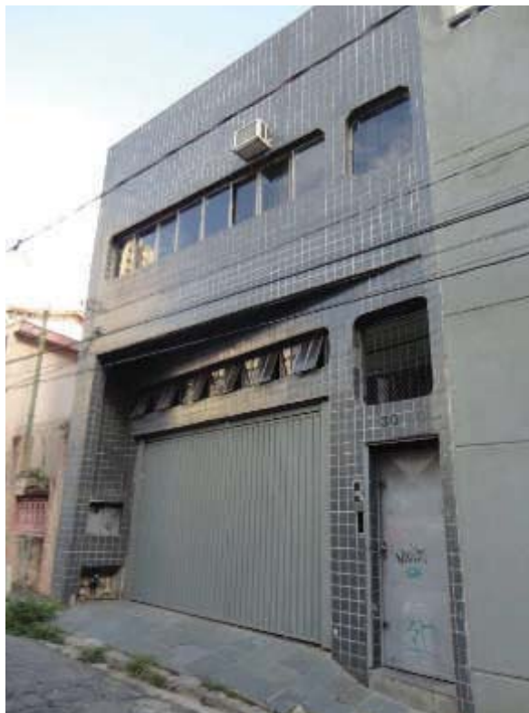
Vista frontal do imóvel avaliando.
