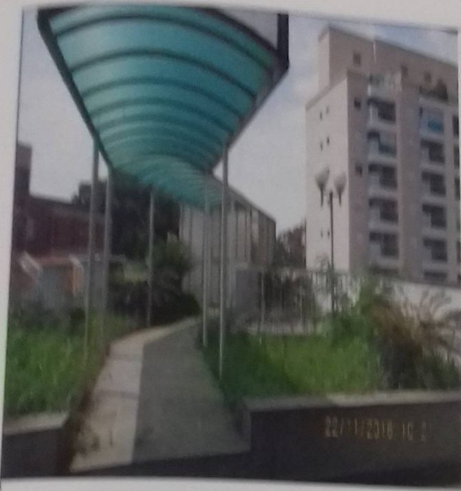
Foto 17 Vista da cobertura do 2º andar.
