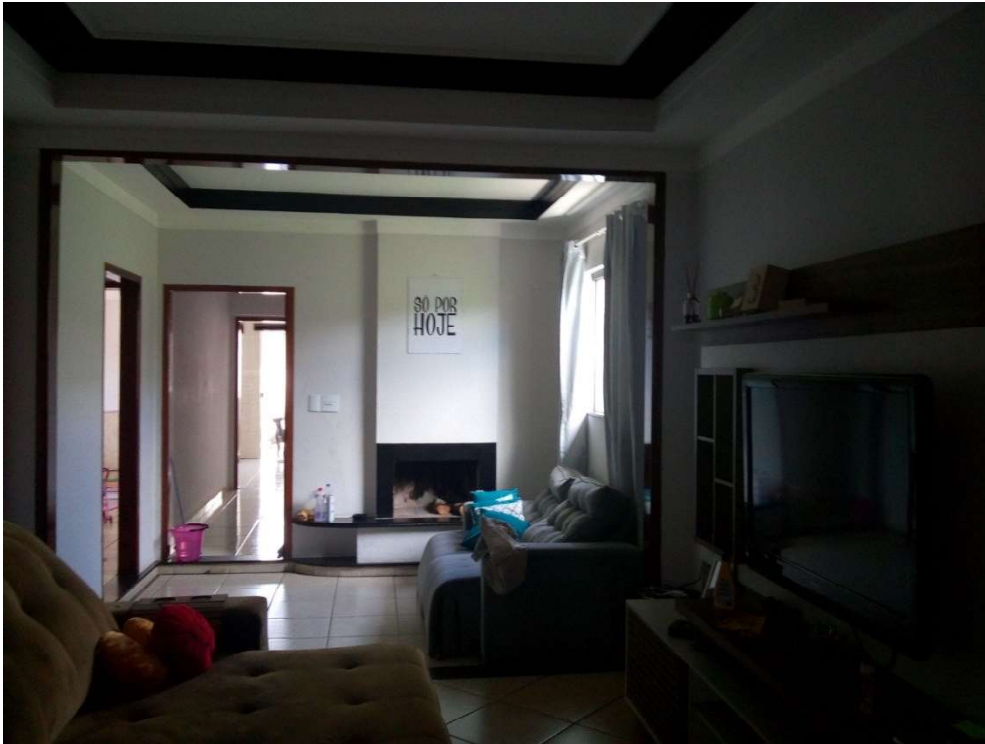
Pisos cerâmicos e paredes com tinta latex sobre massa
