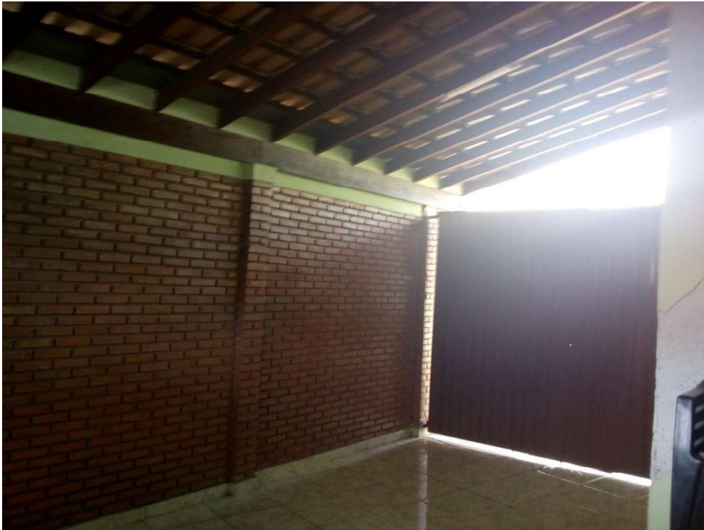
Pisos cerâmicos e paredes com tinta látex sobre massa e telhado aparente
