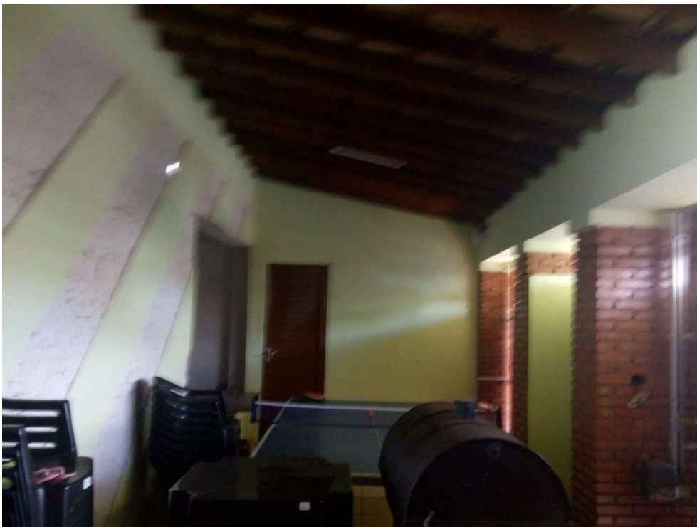
Paredes com tinta impermeável, pisos cerâmicos e telhado aparente
