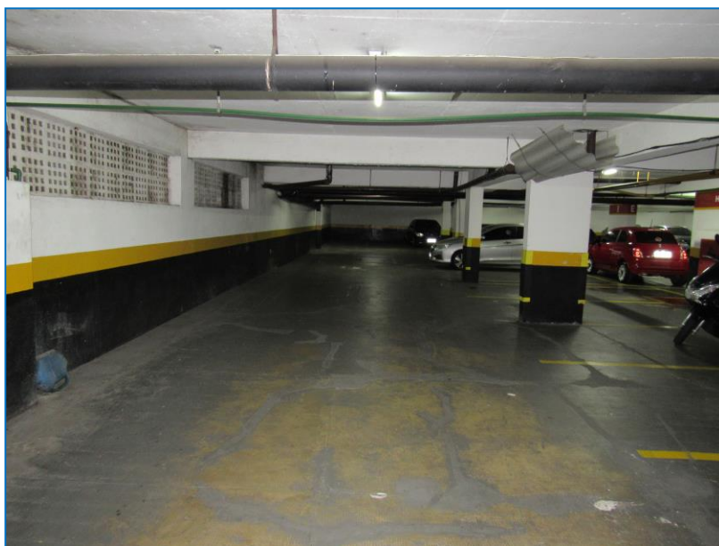
Foto de nº 10 - Vagas de estacionamento, no subsolo.
