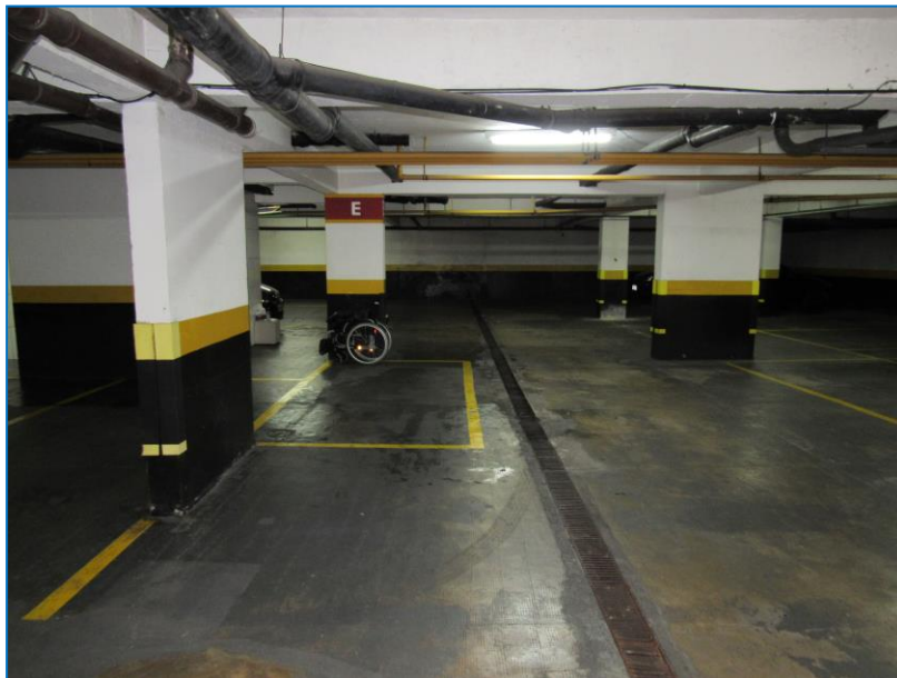
Foto de nº 11 - Vagas de estacionamento, no subsolo.
