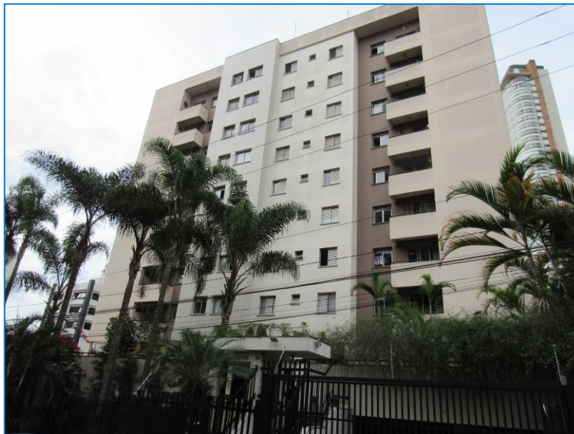
FACHADA DO EDIFÍCIO NEW ORLEANS.
