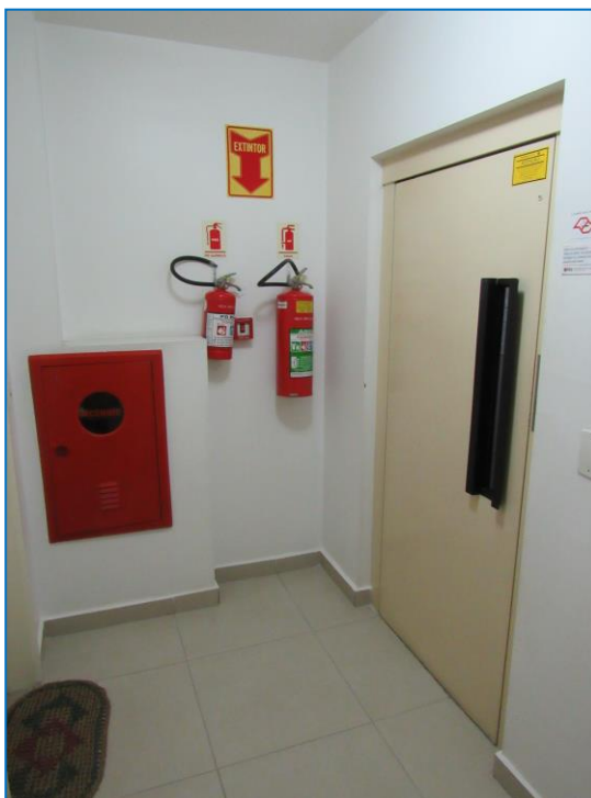
Foto de nº 29- Hall dos elevadores no 6º andar.
