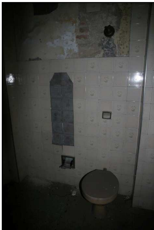
FOTOS 12/13 - Banheiro do apartamento 43, ilustrando a ausência de azulejos na parede que contém as instalações hidráulicas.
