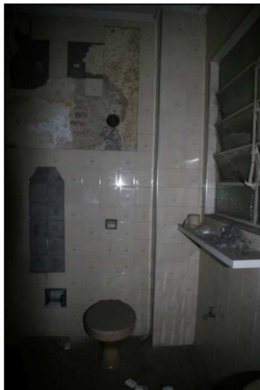
FOTOS 12/13 - Banheiro do apartamento 43, ilustrando a ausência de azulejos na parede que contém as instalações hidráulicas.
