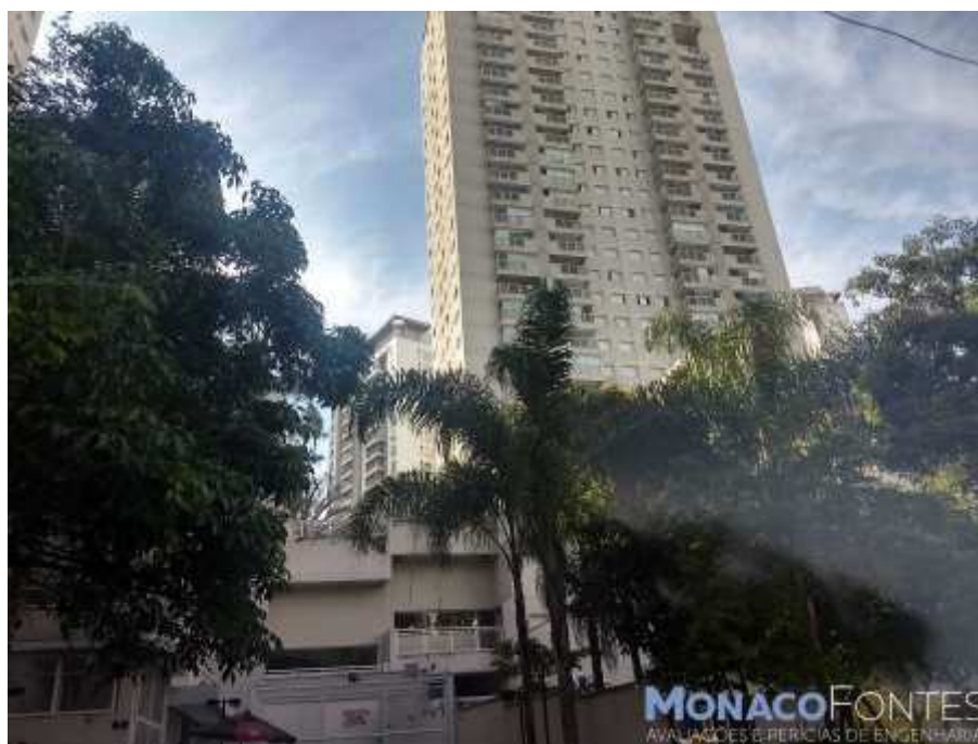
Acima, temos uma tomada da testada do Condomínio In Jardim Sul Street.
