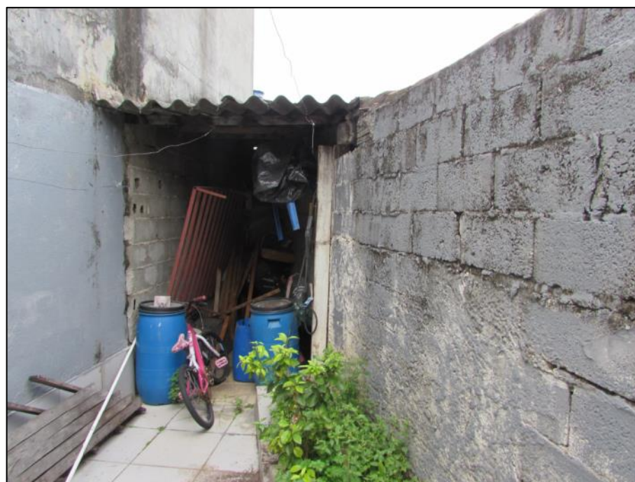
Foto 07: Vista da área dos fundos com piso cerâmico, paredes revestidas com acabamento.
