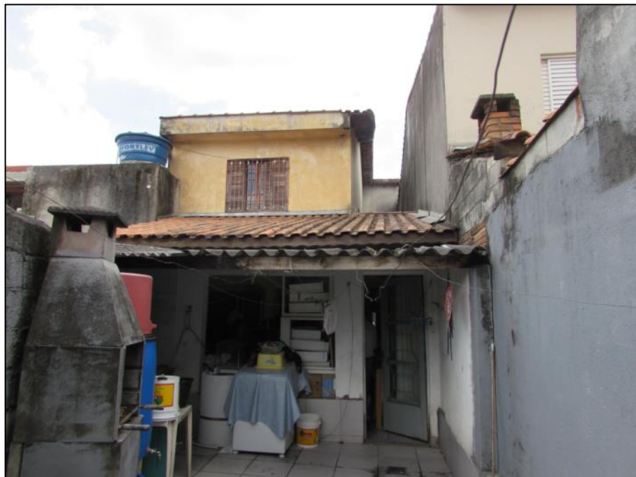
Foto 06: Vista da área dos fundos com piso cerâmico, paredes revestidas com acabamento.
