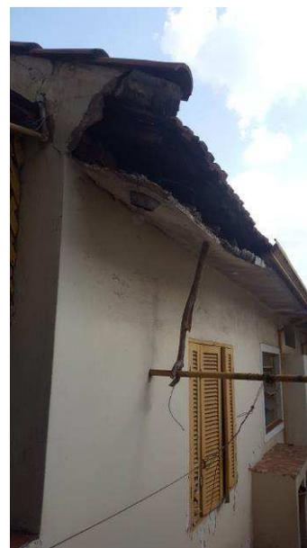
**Foto beiral telhado danificado**
