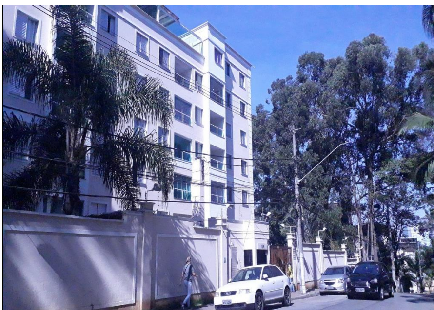
FOTO 1. Fachada do imóvel avaliando.
