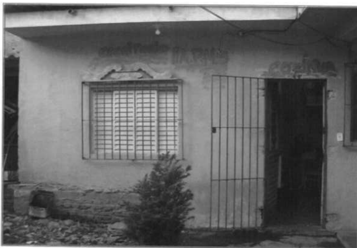
Foto nº 05: Vista geral da fachada do cômodo localizado nos fundos.
