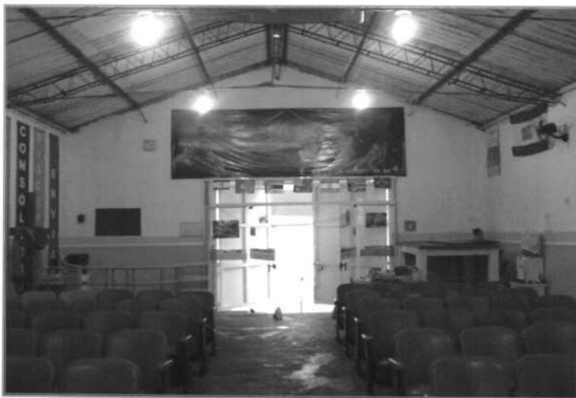
Foto nº 03: Vista interna do galpão, tomada no sentido oposto.
