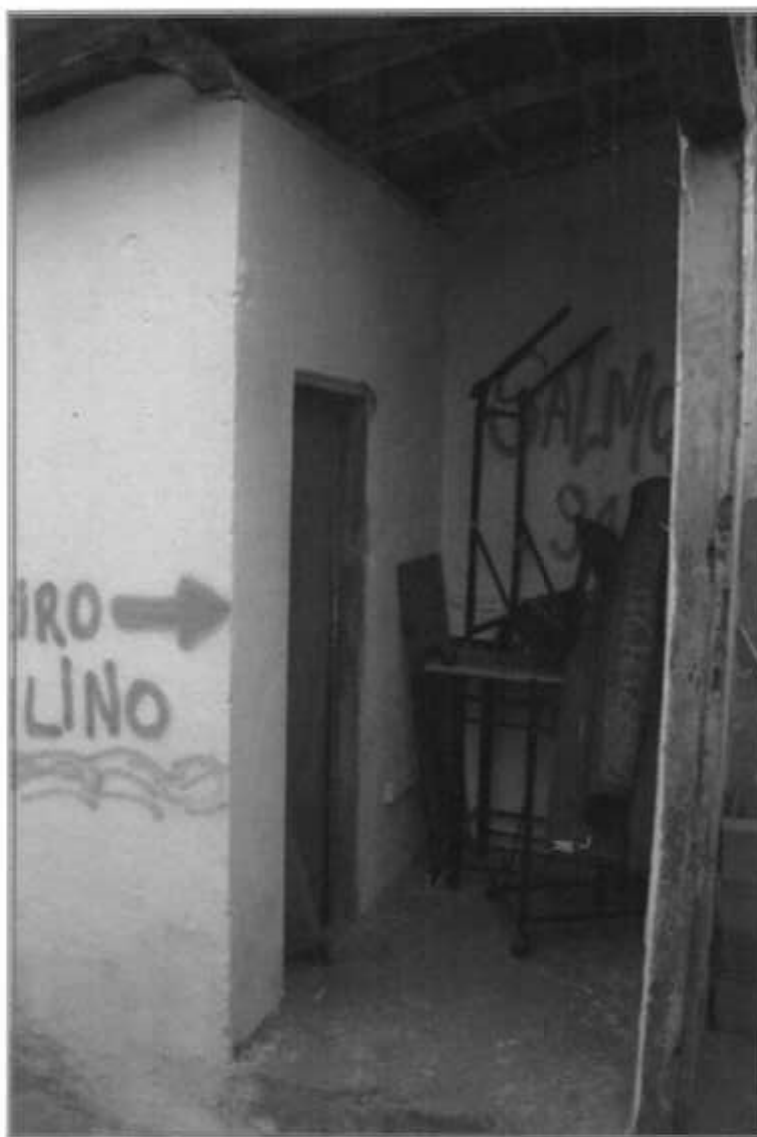
Foto nº 08: Vista parcial do banheiro da edícula.
