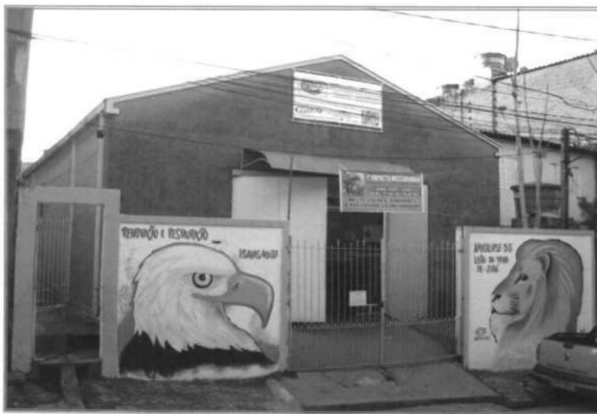
Foto nº 01: Vista geral da fachada do imóvel.
