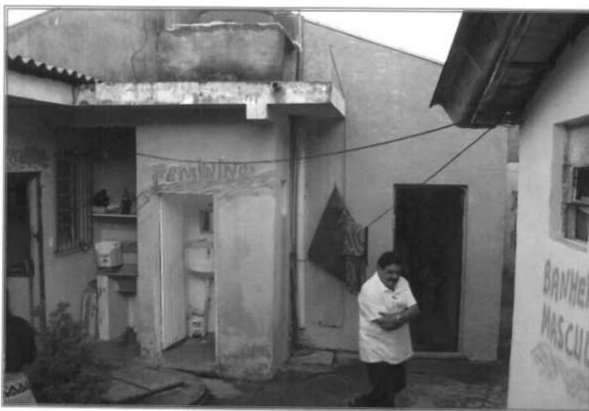
Foto nº 04: Vista geral das edificações localizadas nos fundos do lote.
