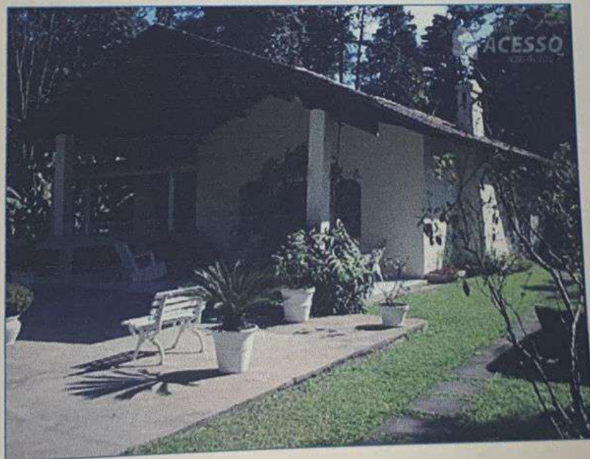
ASPECTOS DA EDIFICAÇÃO.
