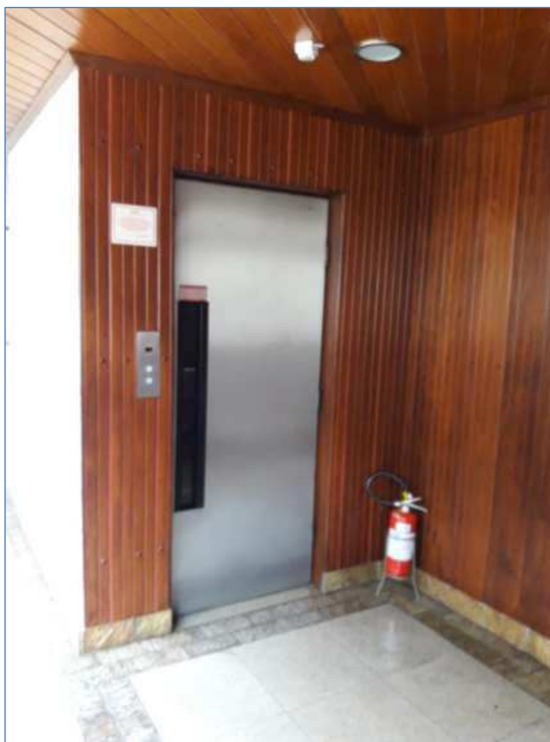
HALL DE ELEVADOR NO PAVIMENTO TÉRREO.
