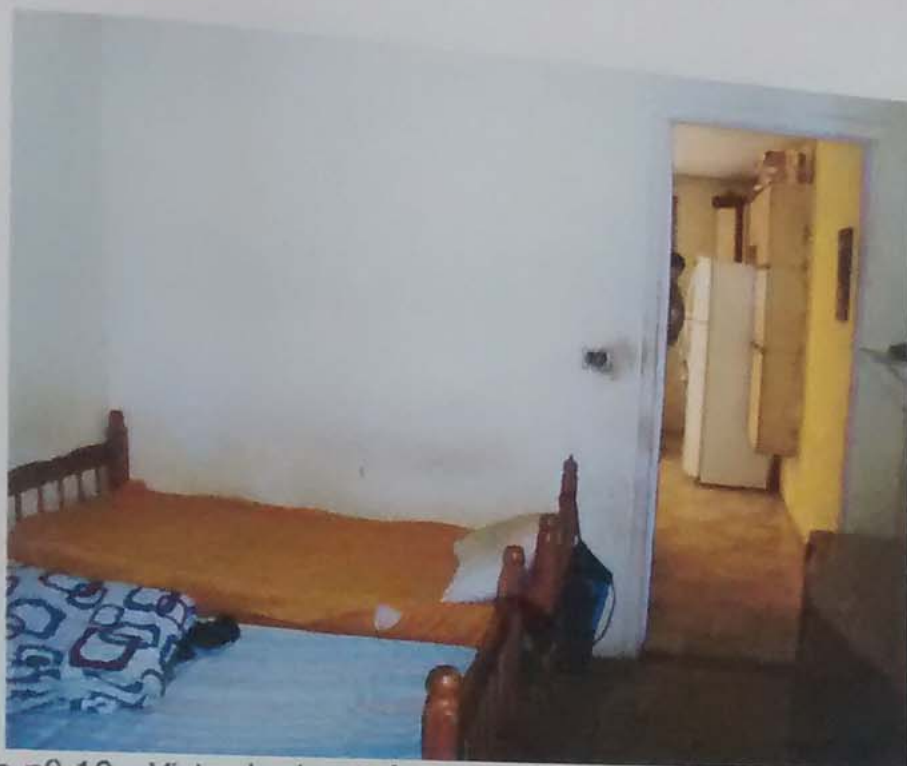
Foto nº 10 - Vista do dormitório e parcial da cozinha da Construção 1
