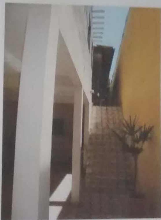
Foto nº 15 - Vista da escada de acesso ao pavimento inferior da Construção 2
