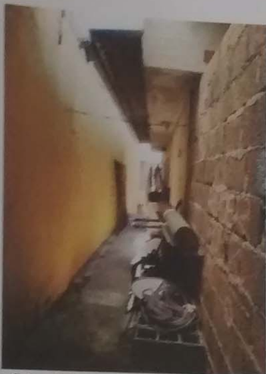
Foto nº 6 - Vista do corredor lateral descoberto
