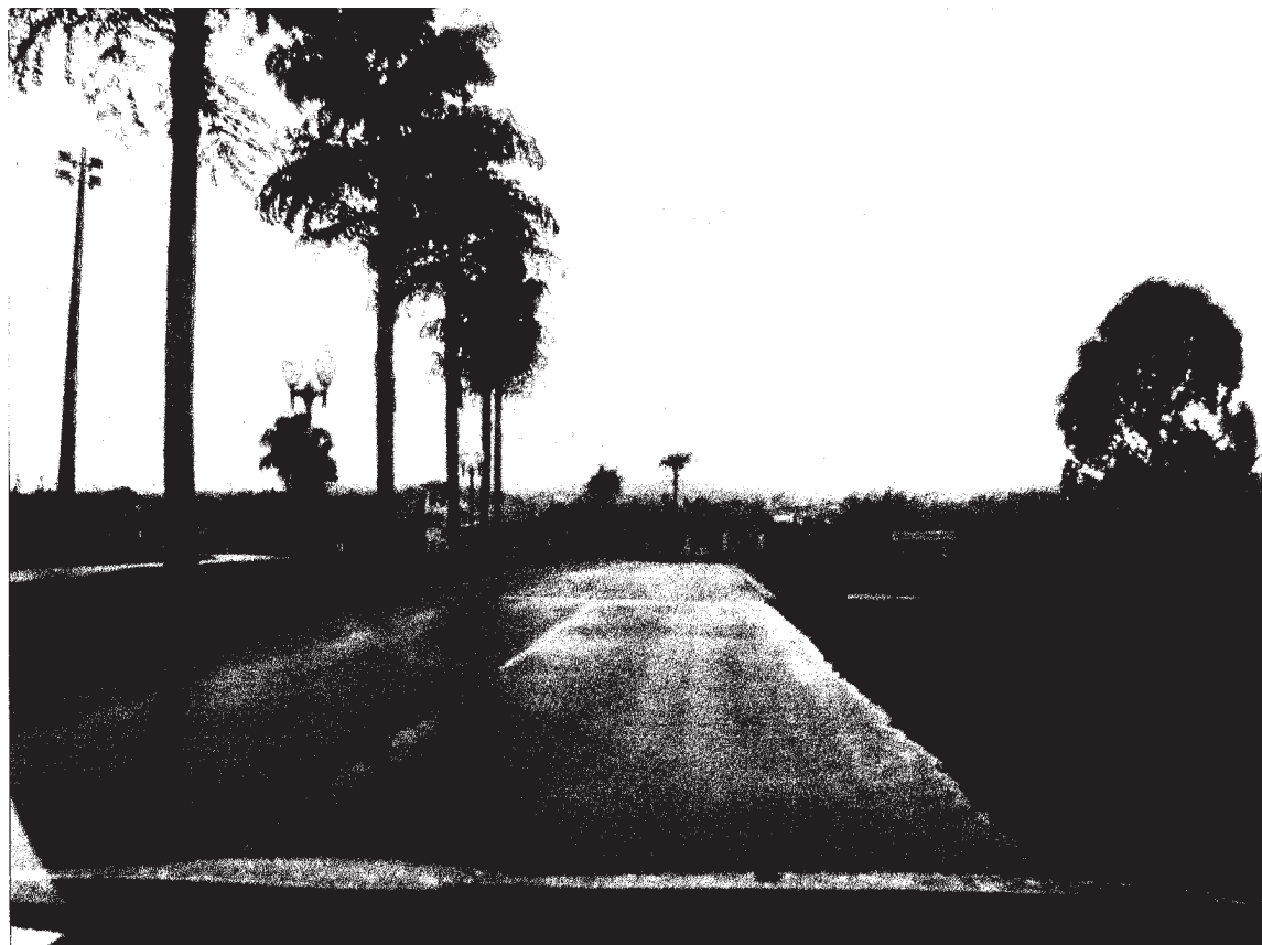
FOTO 02 — Vista da Alameda principal de acesso à portaria do empreendimento.
